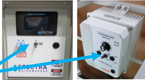
5. Encienda el sistema, y la pantalla de Spectra Connect preguntará: *Has the system been stored with chemicals?* (¿Se ha almacenado el sistema con productos químicos?). Presione *Yes* (sí) para iniciar la secuencia de purgado. **Nota:** La desalinizadora se apagará si la válvula de alivio de presión se deja cerrada durante el modo *Purge* (purgar).
