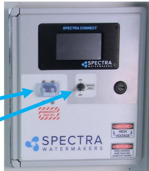
El interruptor de palanca *Run* (ejecución) en el control de velocidad debe estar en la posición *Auto* (automático) tanto para la bomba principal como para la bomba de refuerzo opcional.
